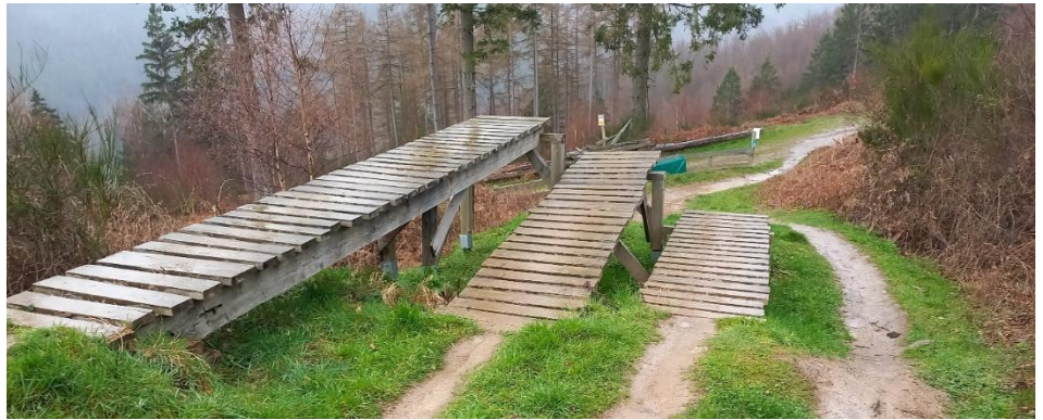
Abbildung 4: Drop-Elemente aus Holz in verschiedenen Höhen
